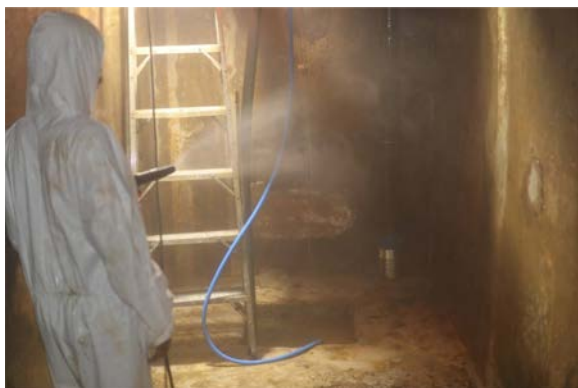
รูปที่ 2-18 การล้างถังสำรองน้ำ
