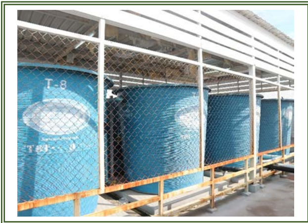
รูปที่ 2-13 ถังสำรองน้ำชั้นใต้ดิน และตลาดฟ้า
