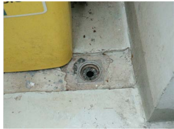
รูปที่ 2-26 ท่อรวบรวมน้ำเสียจากห้องพักมูลฝอย
